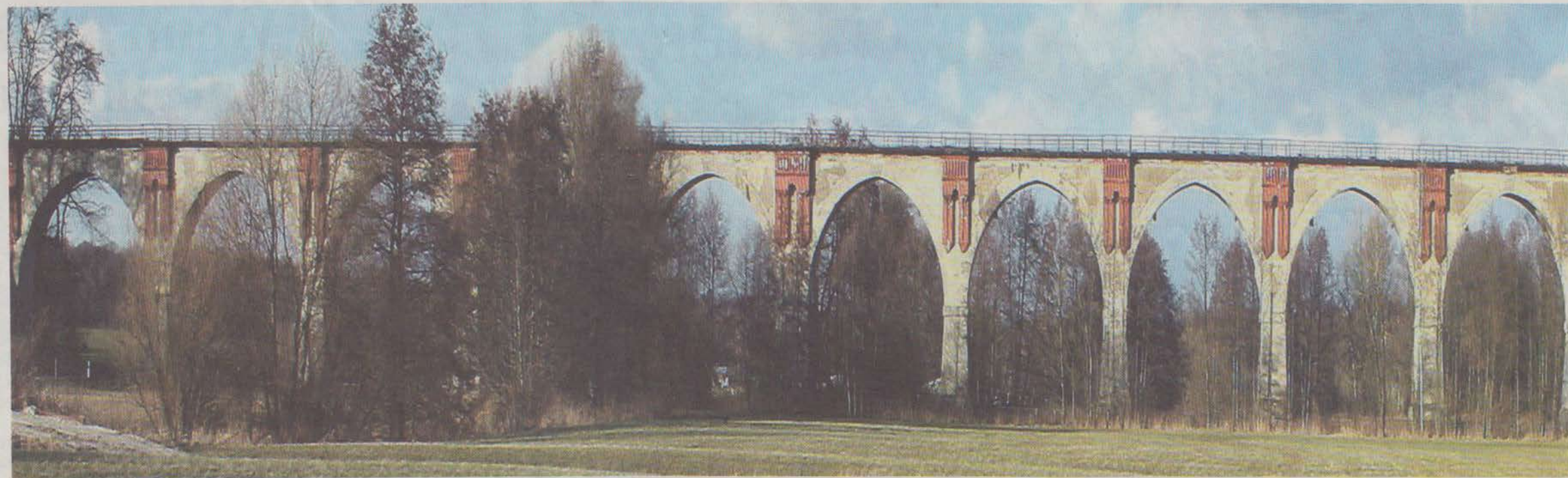
Das Wiesebacher Viadukt ist mit 330 Metern und 17 Bögen die größte Eisenbahnbrücke der Region. Sie ziert auch das Titelbild der Broschüre zum Viaduktradweg.
